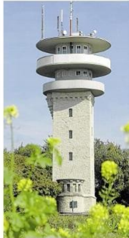
Hell erstrahlt der Baumberger Sandstein, mit dem der Longinusturm gebaut und jetzt saniert worden ist. Foto: Frank Vogel
