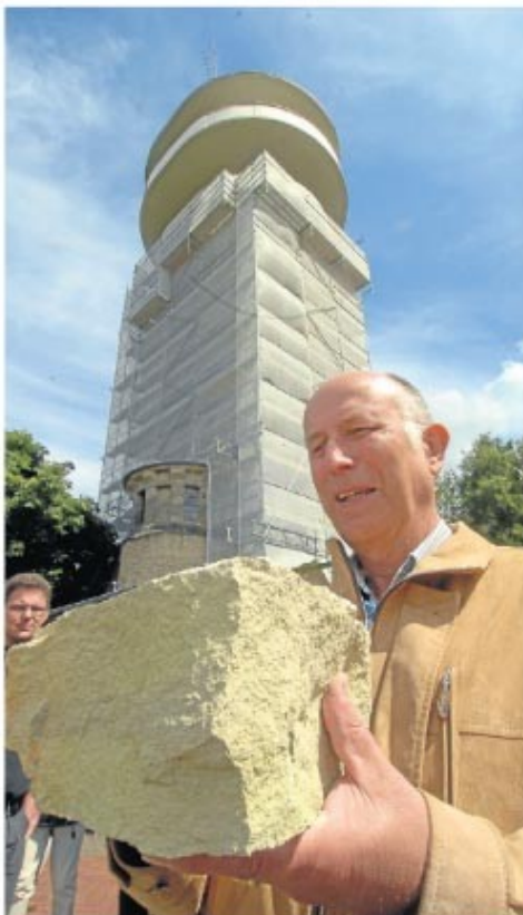
Ronald Fischer mit einem Baumberger Sandstein, der ins marode Gemäuer des Longinus-Turms eingesetzt wird. Foto: Eitzkorn
